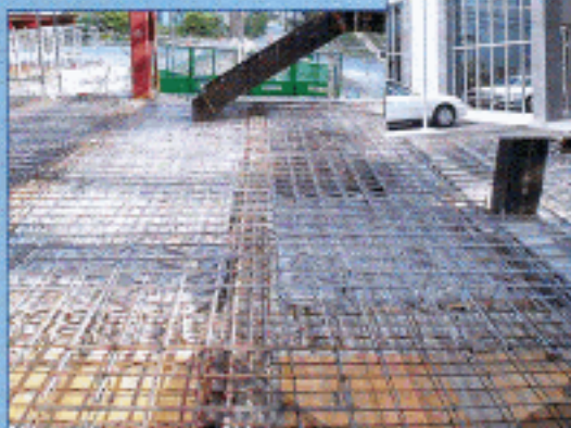
工場事務所区配筋
